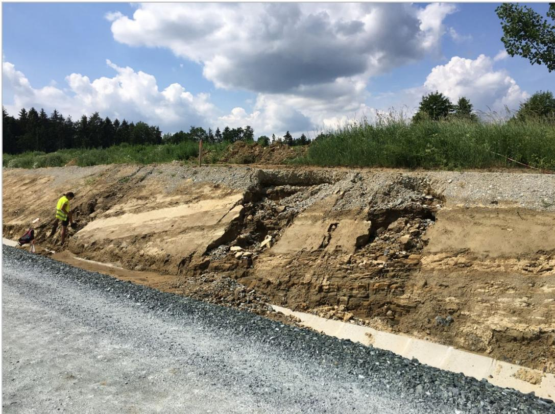
Abb. 2.2.1.14.: „Baulos Kriechspur B50 bei Oberwart“: Erosionsrinnen mit deutlich erkennbarer Schichtung von tonig, schluffigen (dunkel) und sandigen Abschnitten (hell) im Wechsel. Im unteren Bereich ist die Bankung der Schichten besonders gut zu beobachten (Foto: H. Peresson).
