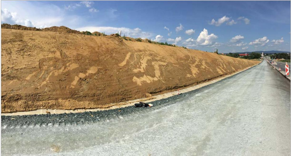
Abb. 2.2.1.27.: „Baulos Kriechspur B50 bei Oberwart“: Überblicksaufnahme des stark tektonisierten östlichen Abschnittes der Baustelle (Foto: M. Peresson).
