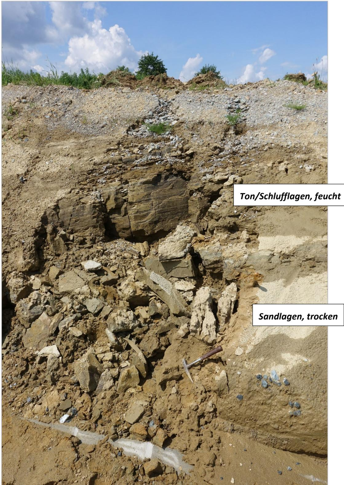
Abb. 2.2.1.19.: „Baulos Kriechspur B50 bei Oberwart“: Im Bereich der Erosionsrinne sind anhand der unterschiedlichen Feuchtigkeit die Wechsellagerungen der Sedimente von Sand (hell) und Schluff/Ton (dunkler) sehr gut zu verfolgen (Foto: M. Peresson).
