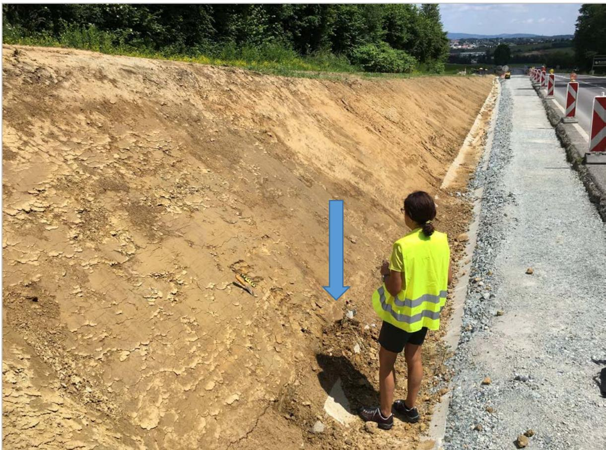
Abb. 2.2.1.10.: „Baulos Kriechspur B50 bei Oberwart“: Ungestörter Bereich am westlichen Startpunkt der Baustelle. Zu Beginn waren die rotbraunen Schluffe und Tone überwiegend massig ausgebildet. Der Pfeil markiert den Probenahmepunkt für die „Probe 1“ (Foto: H. Peresson).
