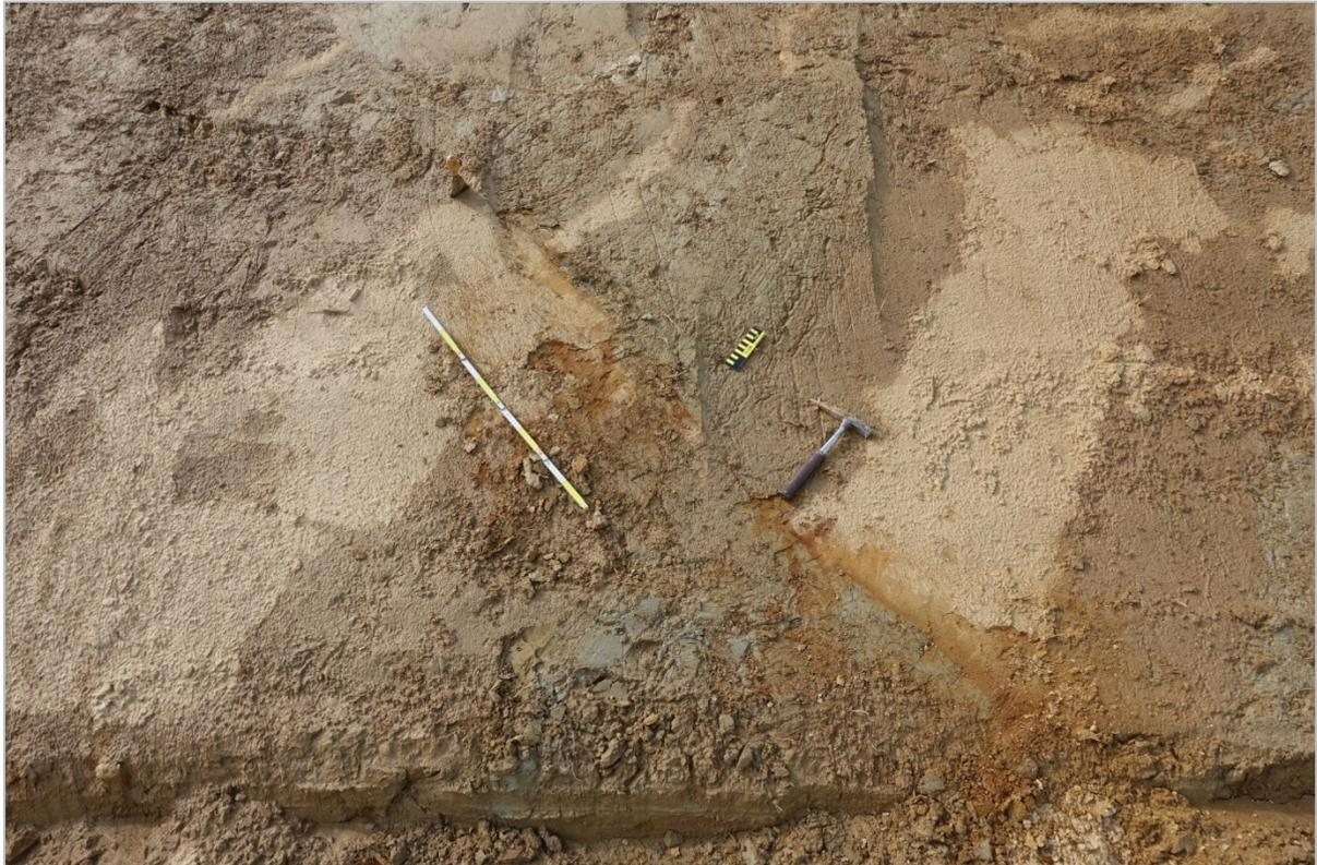
Abb. 2.2.1.34.: „Baulos Kriechspur B50 bei Oberwart“: Tektonisierter östlicher Abschnitt der Baustelle; Aufschiebungsfläche an der Basis (Foto: H. Peresson).
