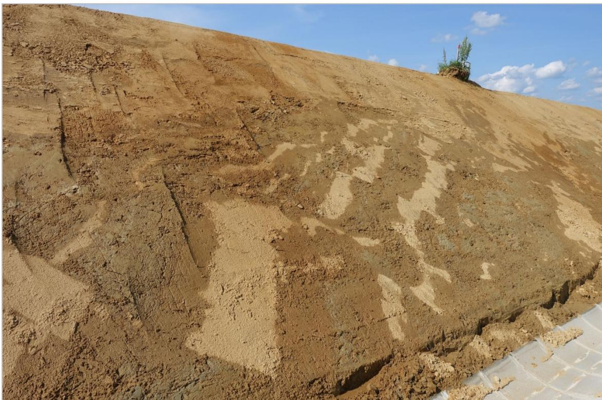
Abb. 2.2.1.28.: „Baulos Kriechspur B50 bei Oberwart“: Tektonisierter östlicher Abschnitt der Baustelle mit deutlich ausgebildeten Abschiebungen (Foto: M. Peresson).
