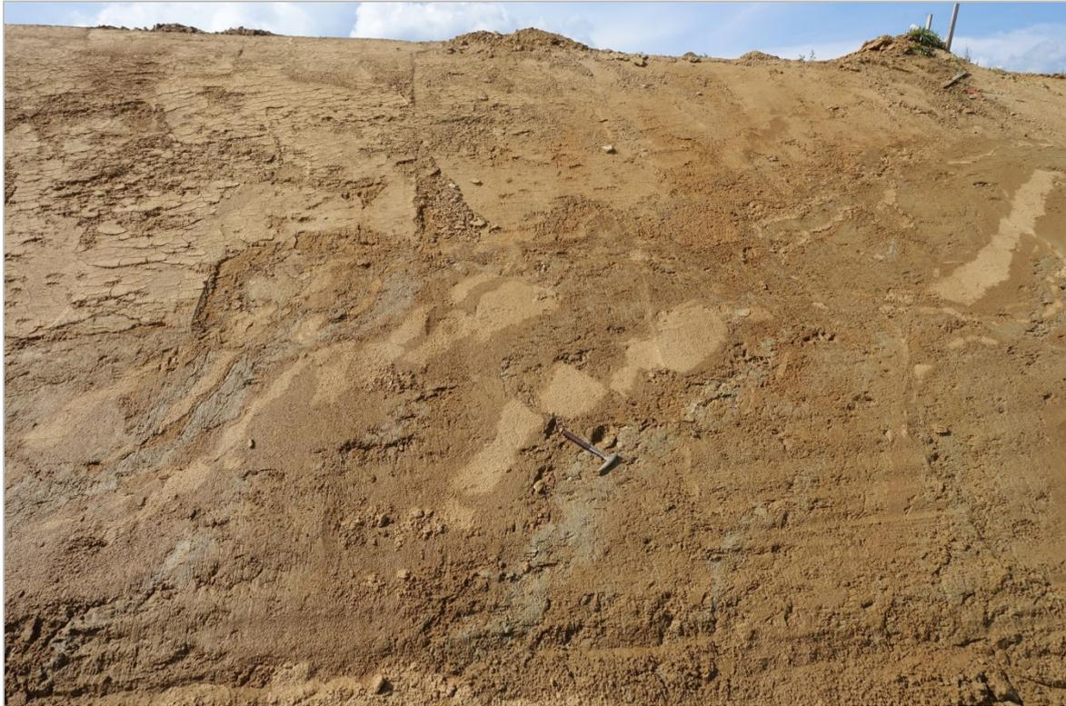
Abb. 2.2.1.29.: „Baulos Kriechspur B50 bei Oberwart“: Tektonisierter östlicher Abschnitt der Baustelle; NE-gerichtete Abschiebungen und Steilstellung der Schichtung (Foto: M. Peresson).
