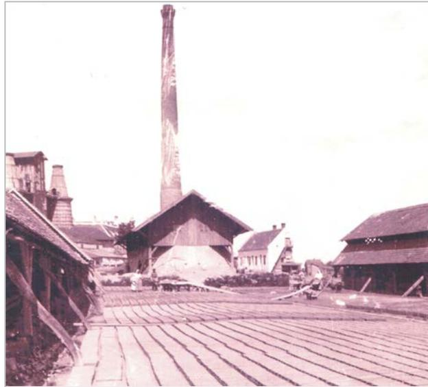
*Abb. 2.1.1.6: Bis 1970 wurde in der Ziegelei Wimpassing „Tegel“ des Pannonium abgebaut, in Ziegel gepresst, getrocknet und gebrannt. Neben dem Schornstein des Ringofens der Ziegelbrennerei ist im Bild links der niedrigere Turm des Kalkbrennofens erkennbar, in dem auch der Mitteltriaskalk des in der Nähe gelegenen Steinbruches gebrannt wurde (Aufnahme um 1920; Reproduktion mit freundlicher Genehmigung der Gebrüder Tschiedel, Wimpassing).*
